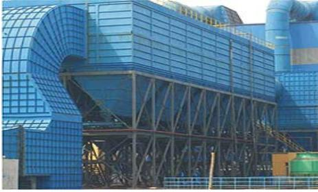
• 长袋离线脉冲除尘器广泛用于冶金行业炼钢高炉原料喷煤制备等工厂、建材、
