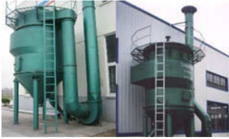
ZC(LPD)型机械回转反吹扁袋除尘器及系列采用园形体结构受力均匀,抗爆性
